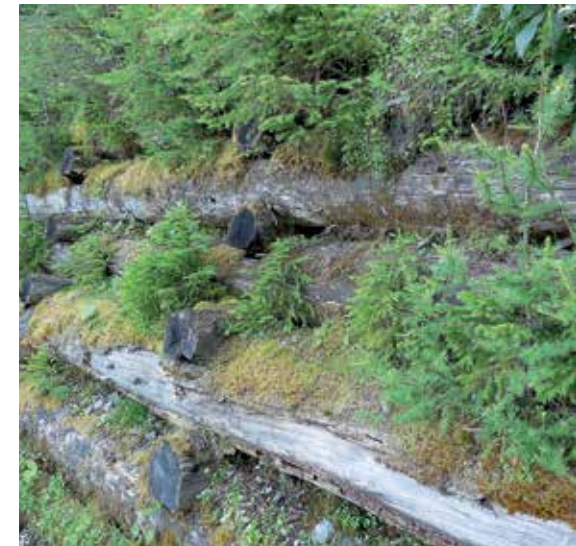
Strukturreiche Oberböschung auf Holzkrainerwand.
